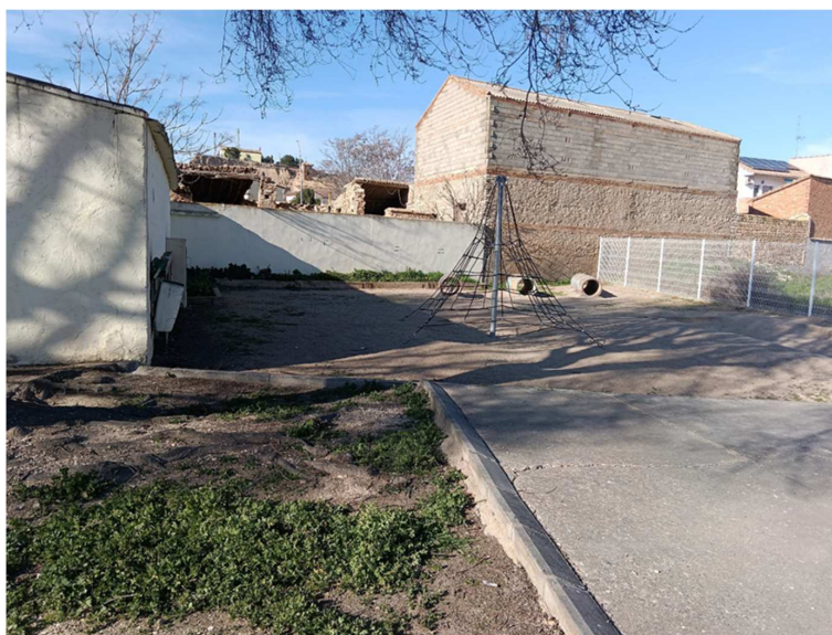
Esquina derecha del área de actuación (ubicación de la fuente) y, al fondo, tubos de hormigón a retirar
