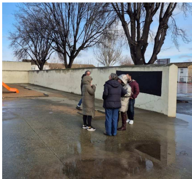
Zona de actuación del pavimento con formación de charcos en zona de paso entre patios desde el de 2º Ciclo de Infantil
